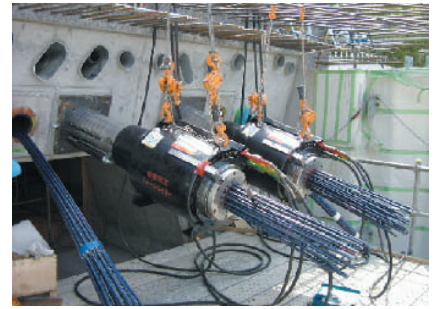
●写真2——シムプレートを設置した緊張状況
