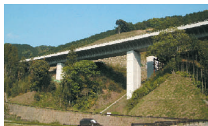
●写真1——完成状況
