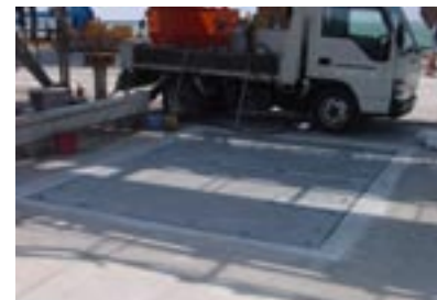
栈橋上面保護層としての利用 Application for Floor Slab of Jetty Structure (upper surface)
