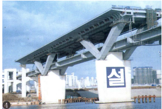
그림 5.4 청담대교 V형 레그 설치 광경
